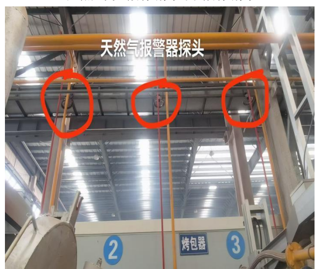
铝合金熔铸车间天然气报警器探头
