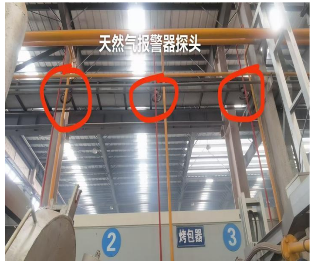
铝合金熔铸车间天然气报警器探头
