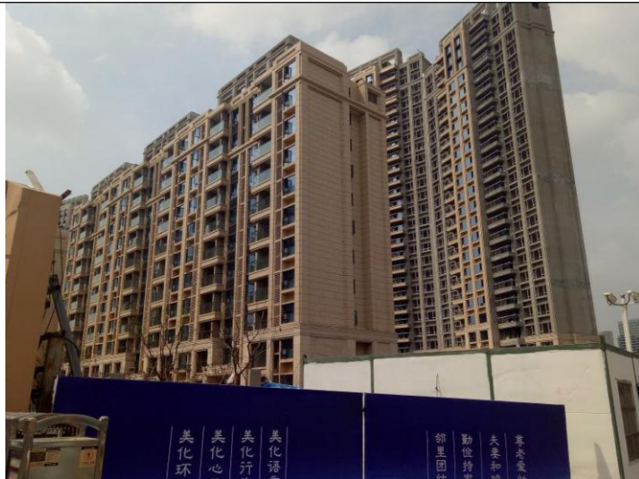
附图 3-12 住宅楼外观
