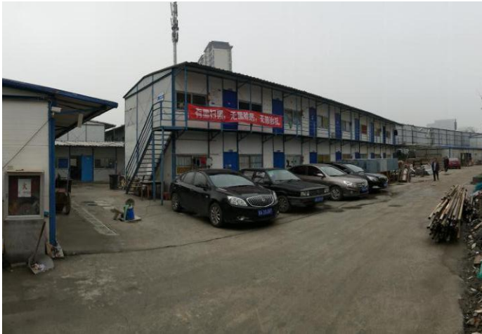
西南：施工单位生活区，施工完成后拆除为空地
