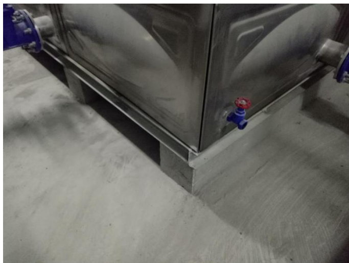
附图 3-14 风机房减振降噪设施
