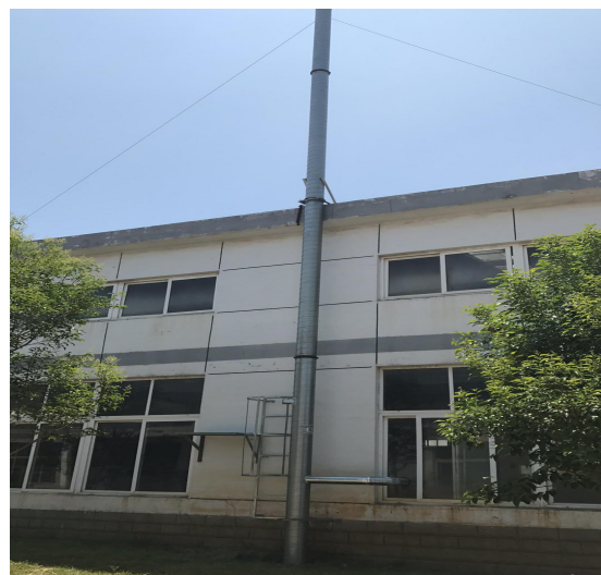
抛丸布袋除尘器及其排气筒
