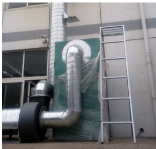
熔化、压铸废气除尘器及其排气筒
