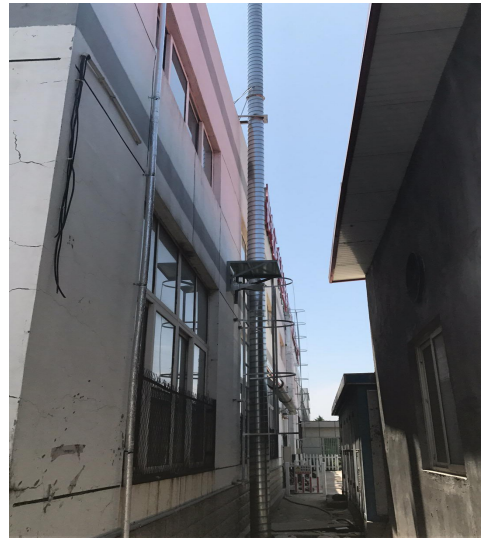
时效炉废气排气筒
