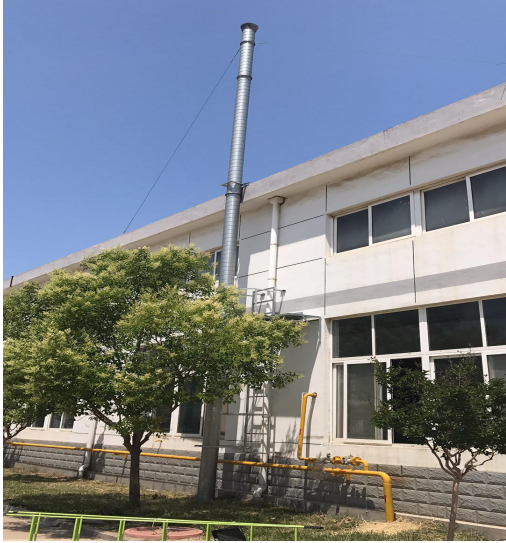
长棒炉废气排气筒
