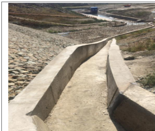
初期坝排洪沟
