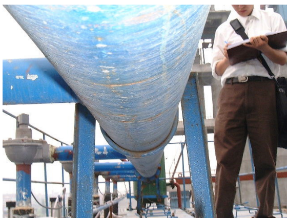
图 2. 气包底部没有安装排污阀。
