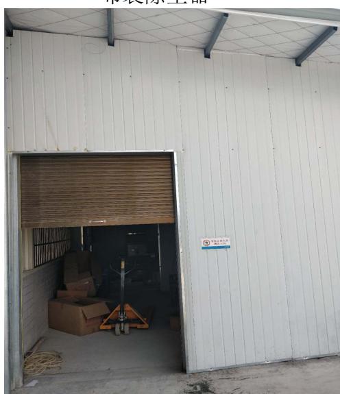
水口料破碎车间
