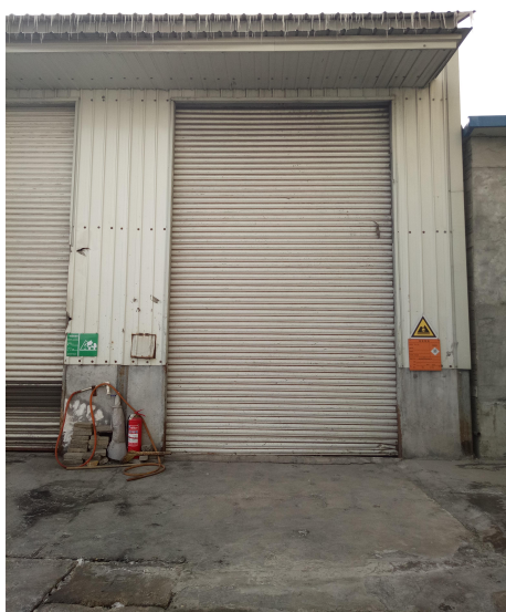
图 7-5 飞灰暂存间（危废暂存间）
