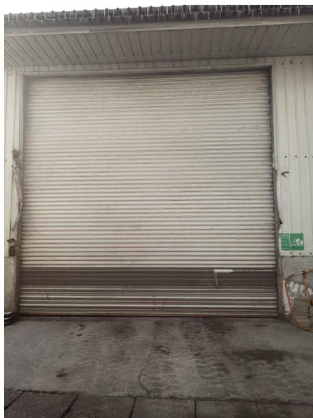
图 7-6 炉渣暂存间（一般固废暂存间）
