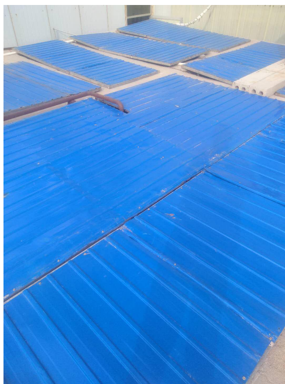
图 2-7-6 污水处理池加盖
