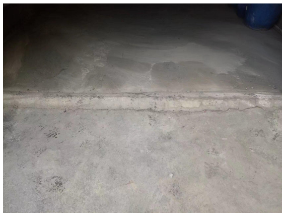
图 7-8 飞灰暂存间（危废暂存间）围堰
