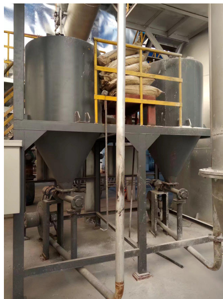
图 7-2 石灰/活性炭喷射脱酸
