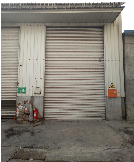
图 7-5 飞灰暂存间（危废暂存间）
