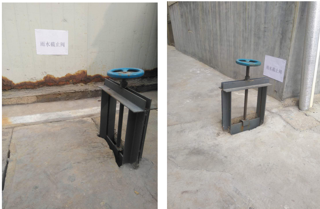
图 2-7-5 雨水截止阀标识
