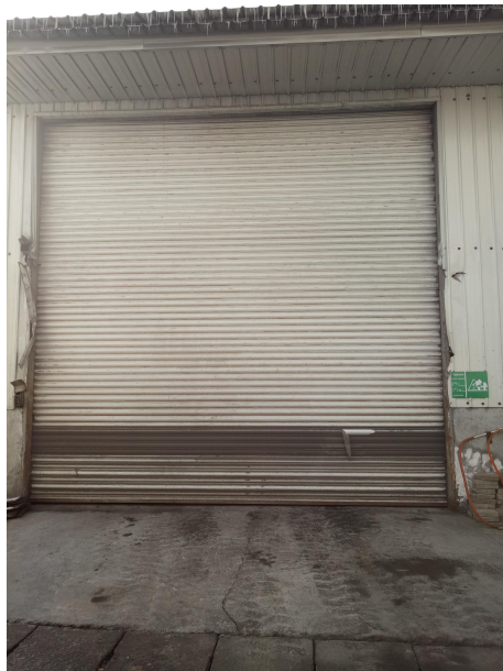
图 7-6 炉渣暂存间（一般固废暂存间）
