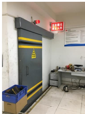
图 6-2 三号探伤室控制操作室
