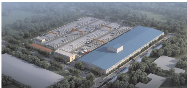
公司一期厂区鸟瞰图
