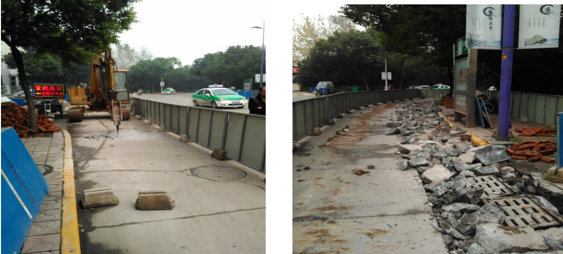
图19 九龙街海关积水改造施工现场
