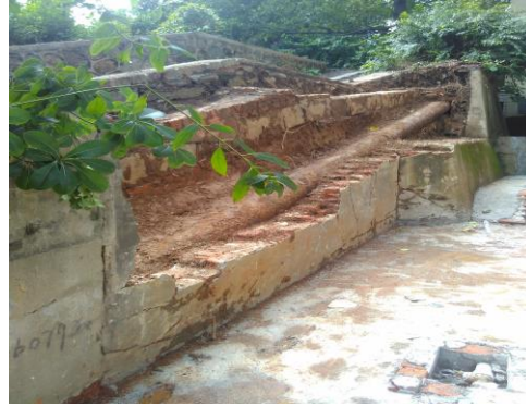
图 16 三里街施工现场
