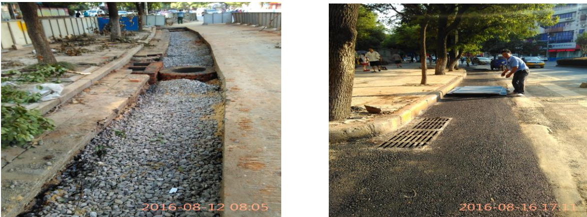
图20 十里大道积水改造施工现场
