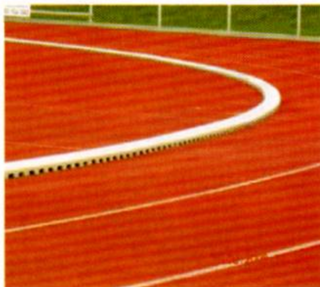
运动场排水沟
