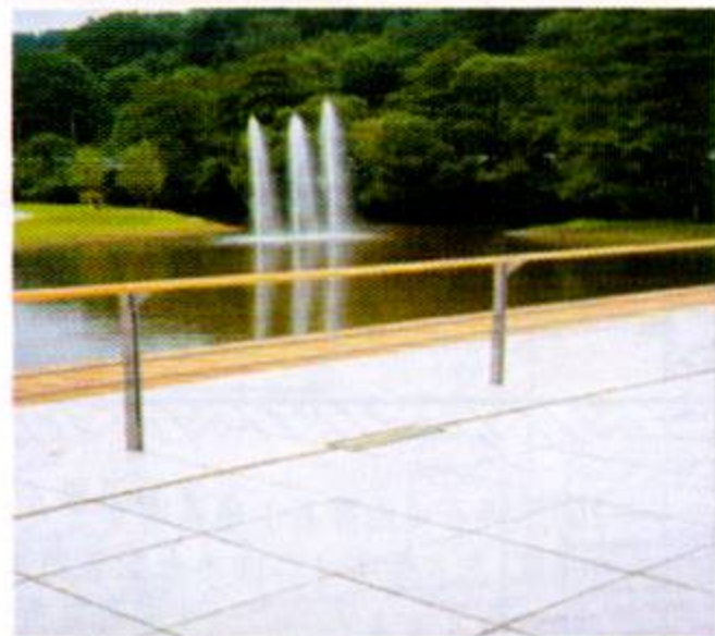
缝隙式排水沟
