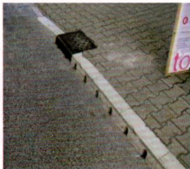
路缘石排水沟
