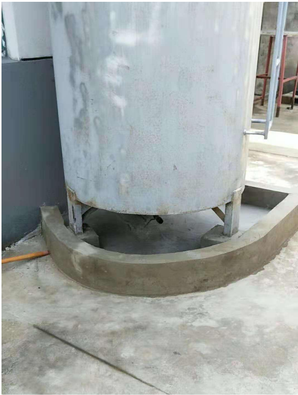
附图 5-3 储油罐围堰
