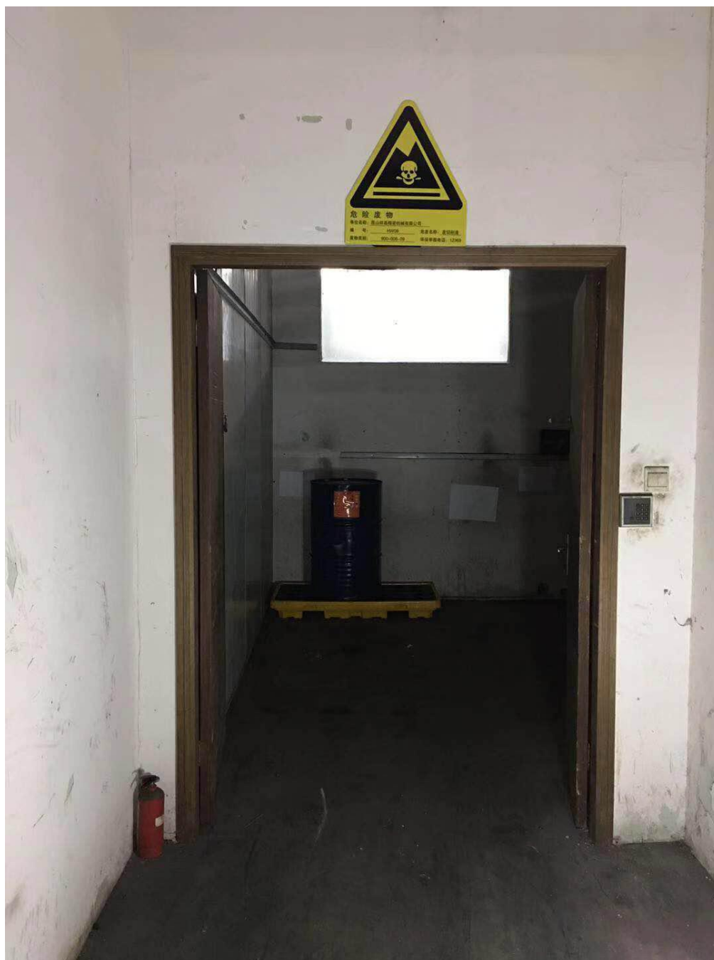
附图 5-2 危险固废暂存点
