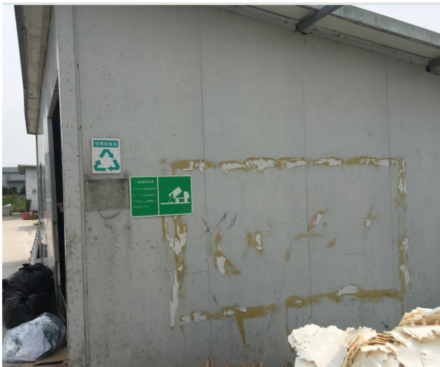
一般固废堆场
