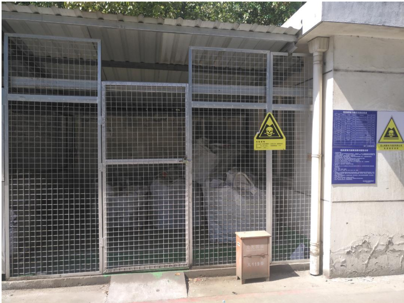
危险废物存放区
