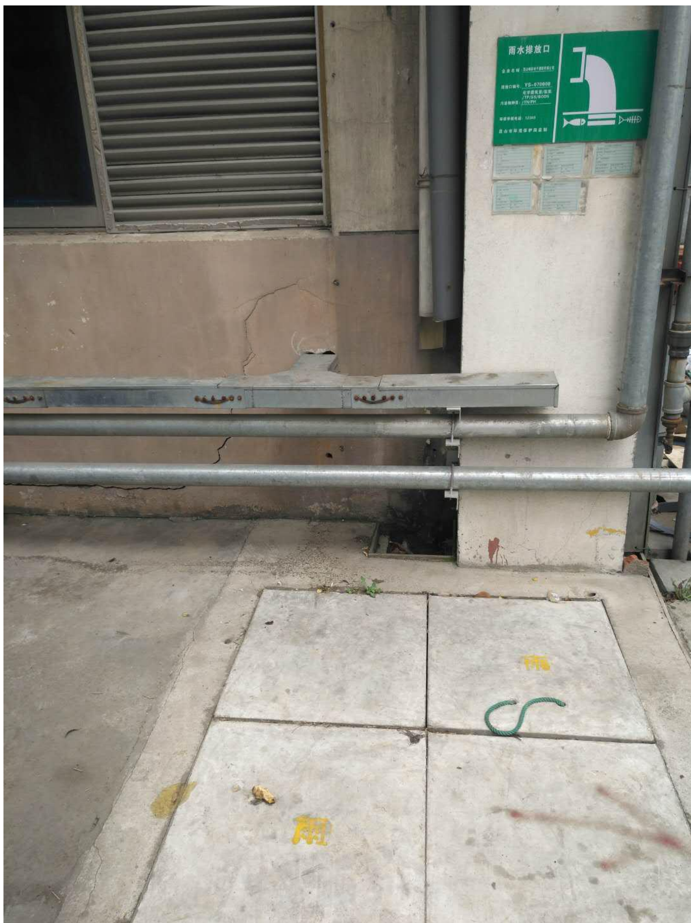
富利路雨水排放口
