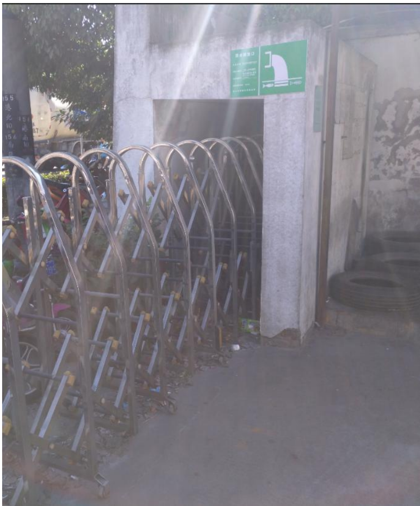
沪光路雨水排放口
