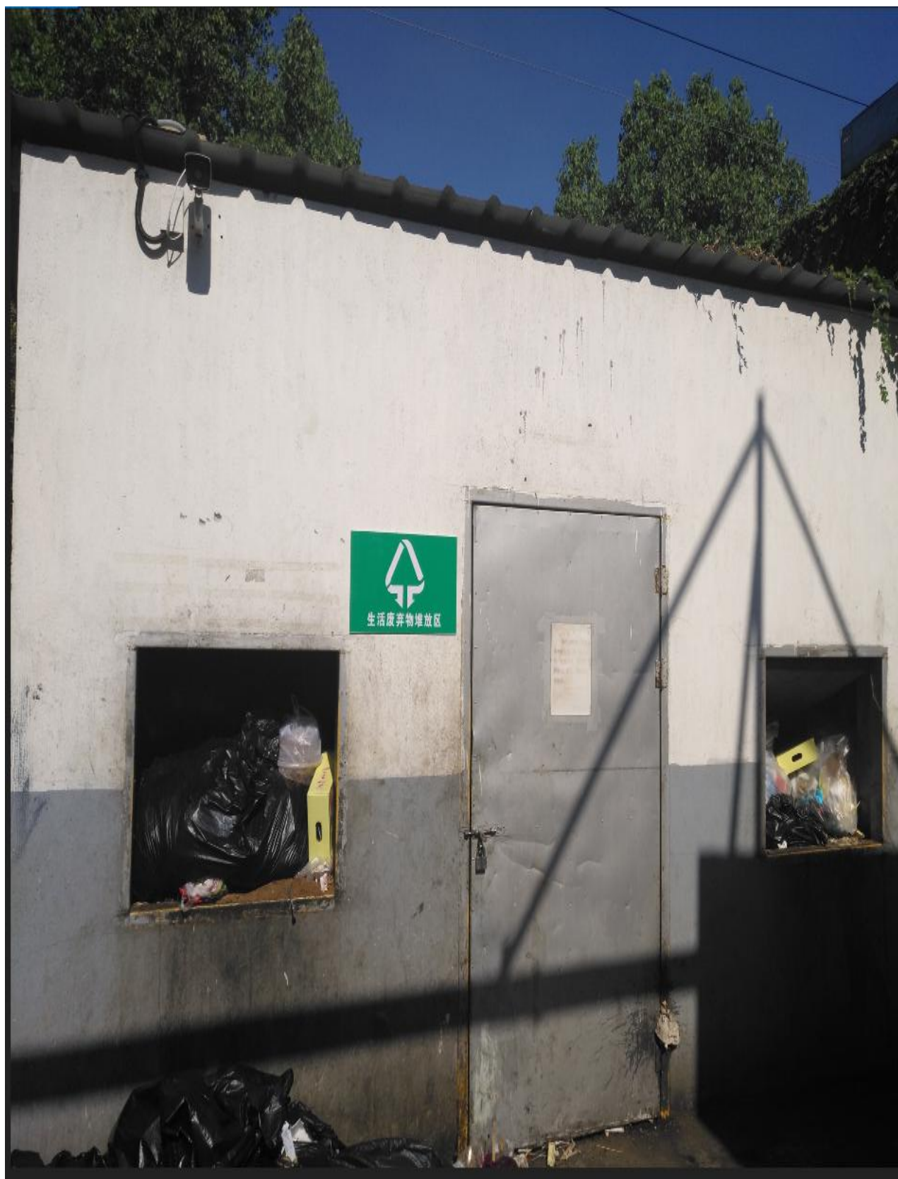
生活垃圾堆放区
