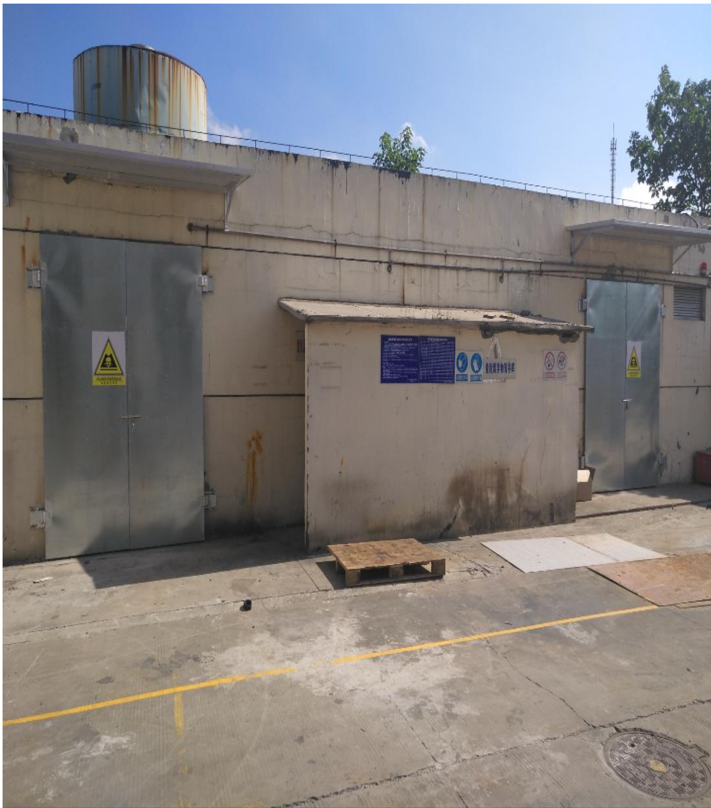
危险废物存放区
