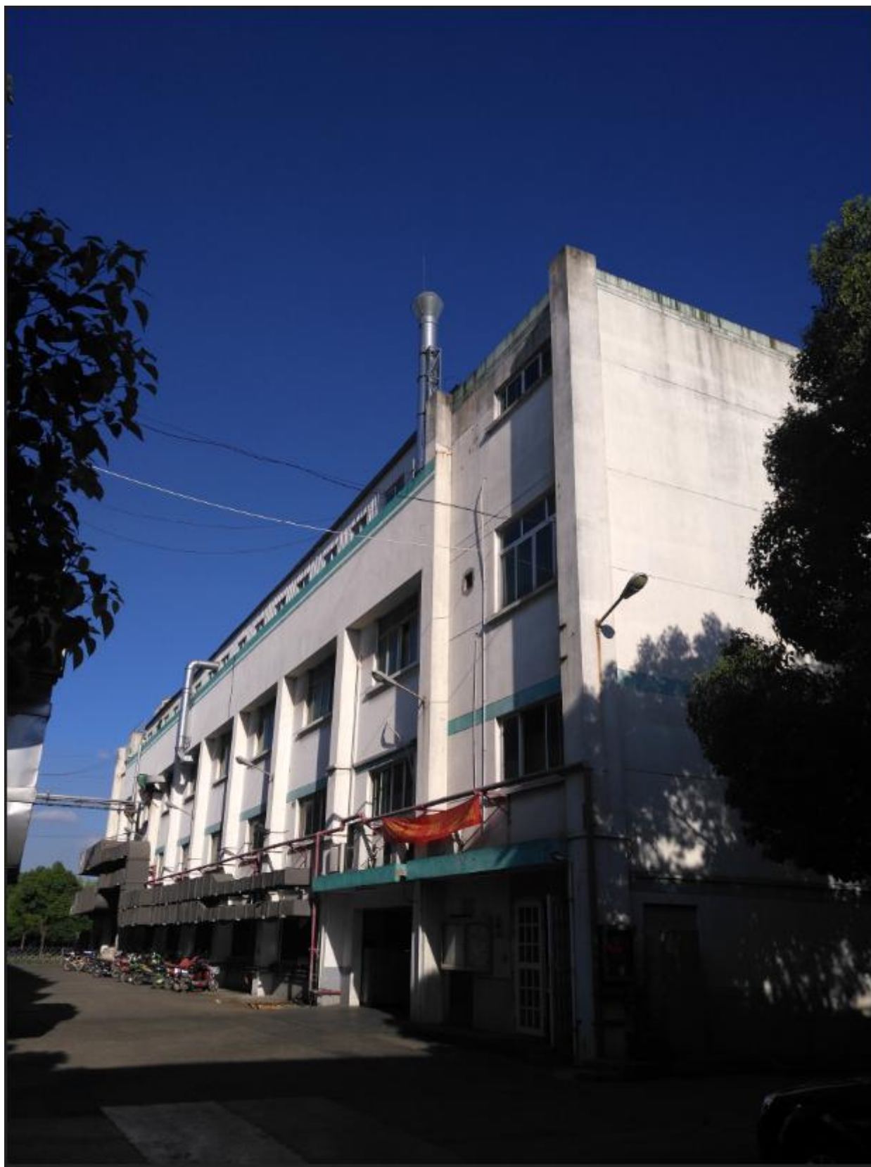
印刷车间排气筒
