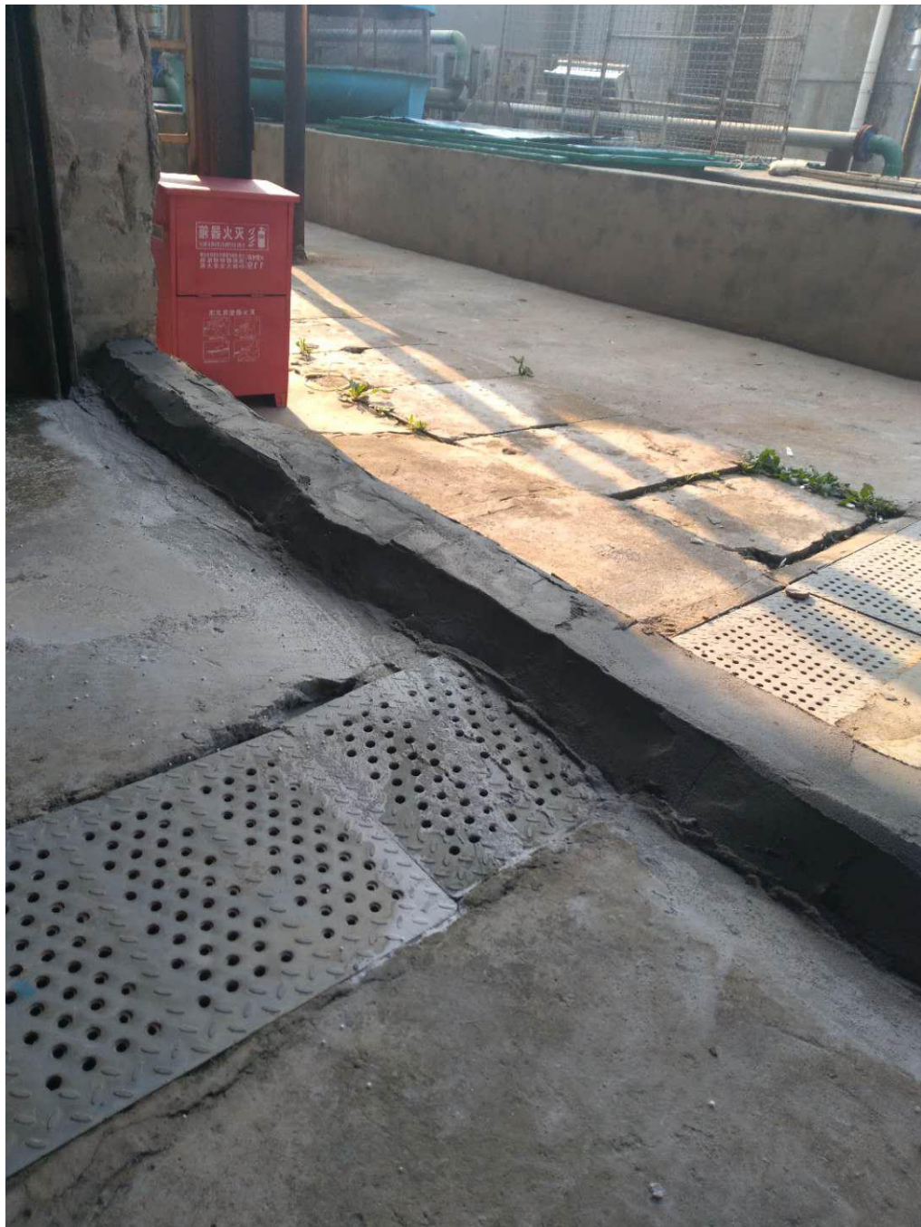
附图一加盖水槽与加盖冷却水池（冷却塔回用水）
