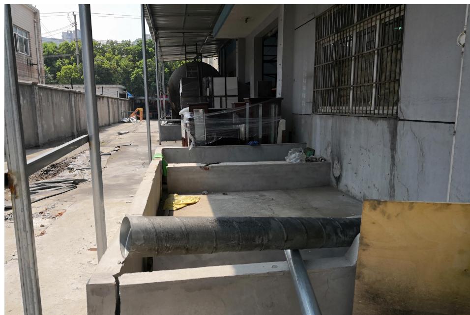
另一侧储罐已拆除（现场留一个储罐）
