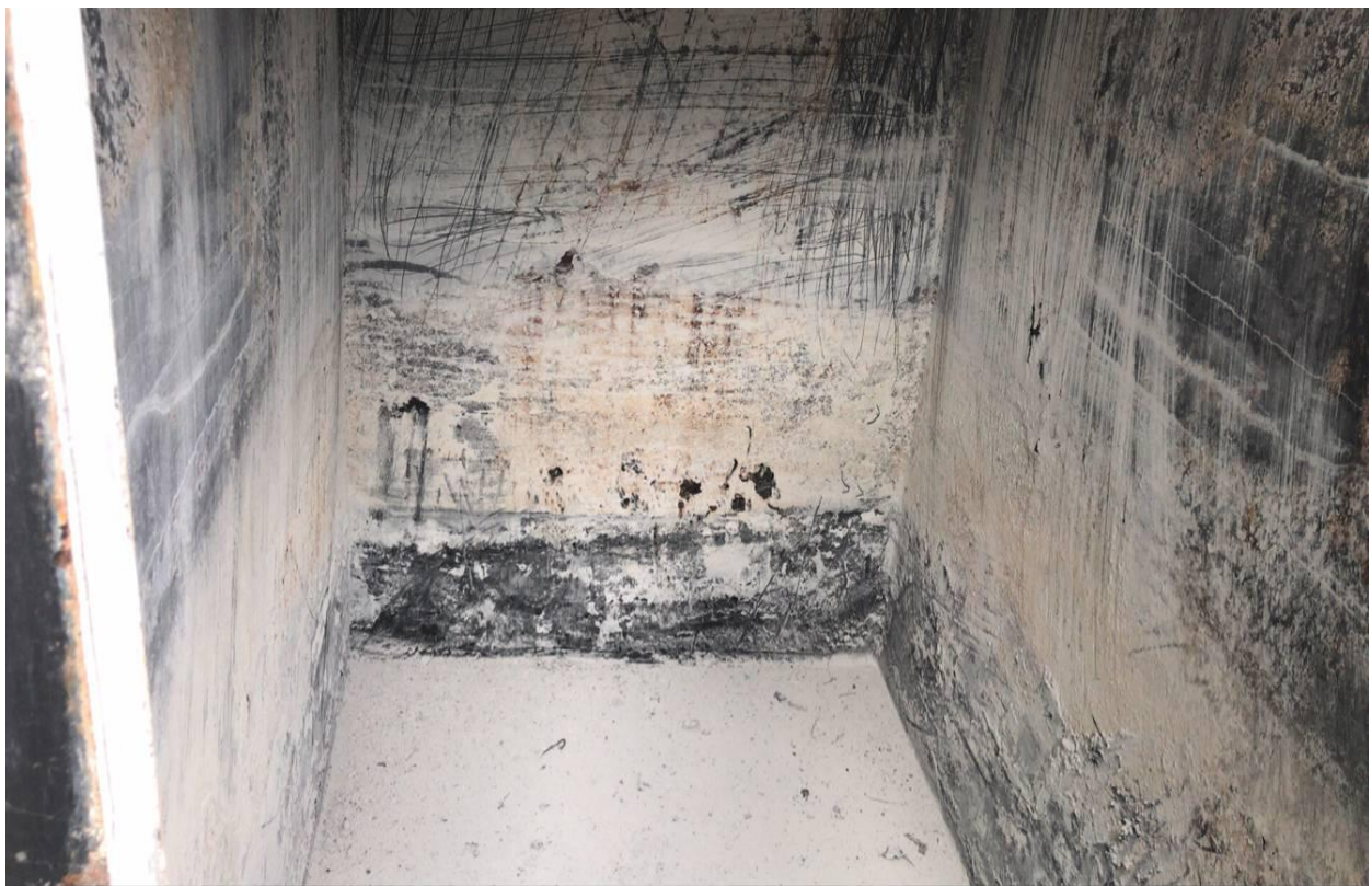
废气处理设备下方以前为水箱，先已清空
