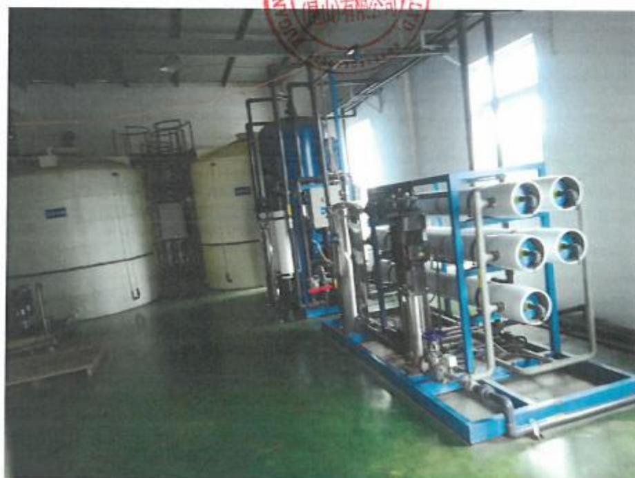
C 区污水站
