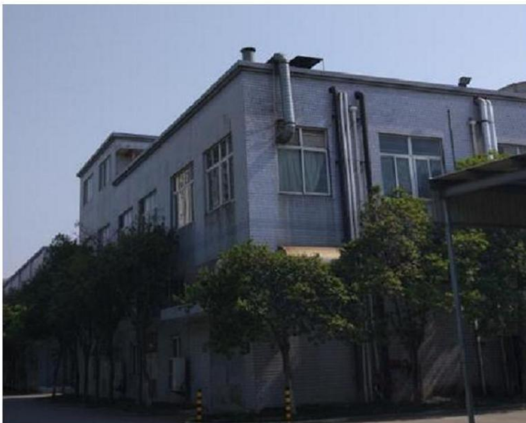
焊锡废气排气筒
