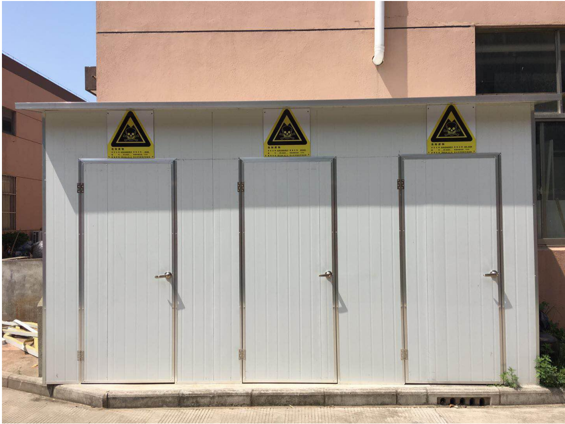
危废贮存场所
