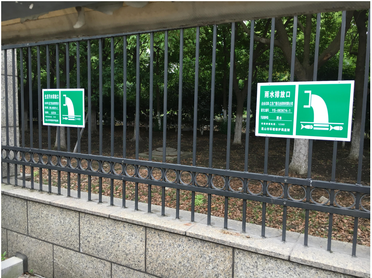
生活污水、雨水排放口
