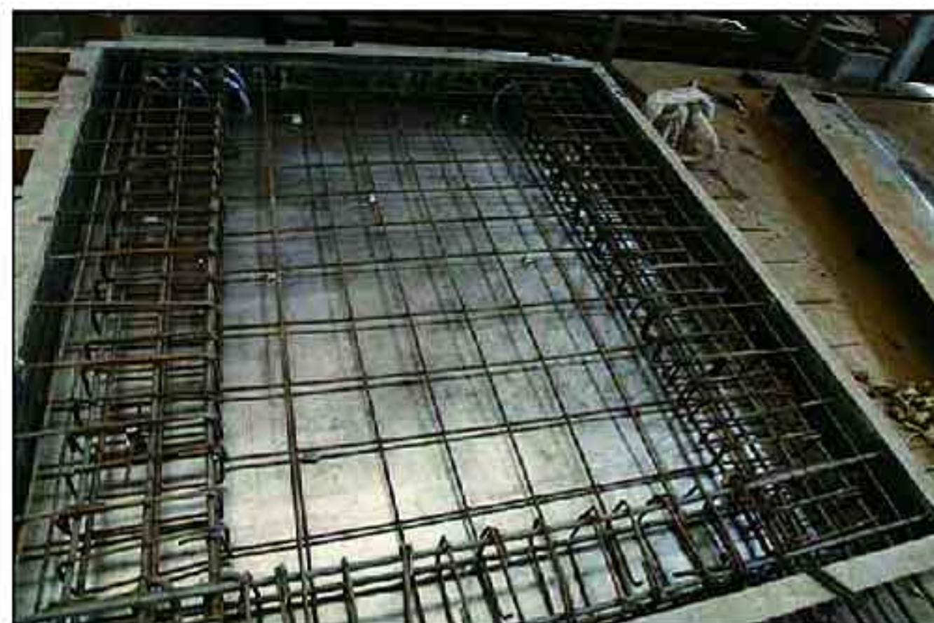
预制墙板内置钢筋局部（二）
