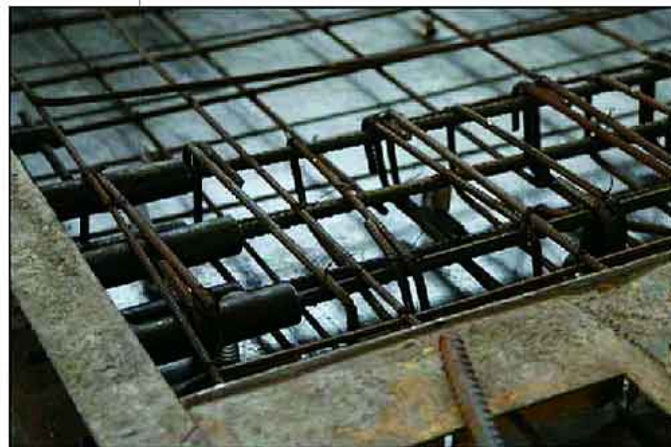
预制墙板内置钢筋局部（一）
