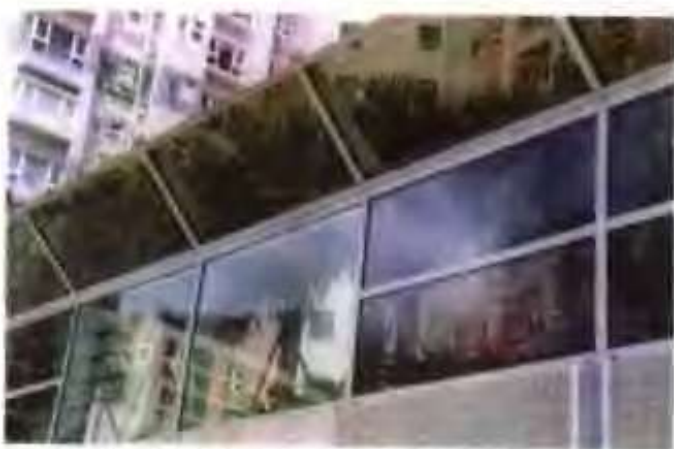
折弯式全透明全反射声屏障
