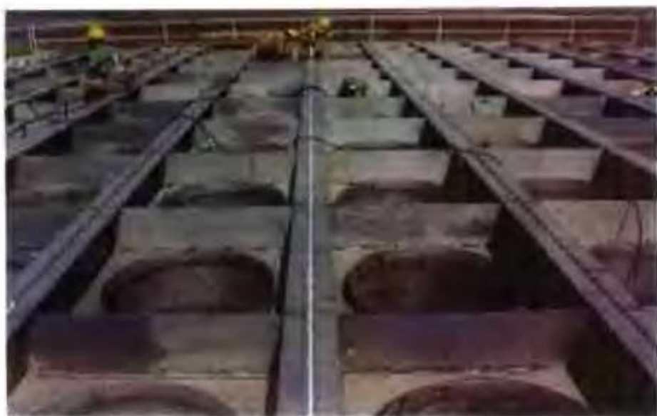
大型航空发动机试车台排气口蜂窝式消声器
