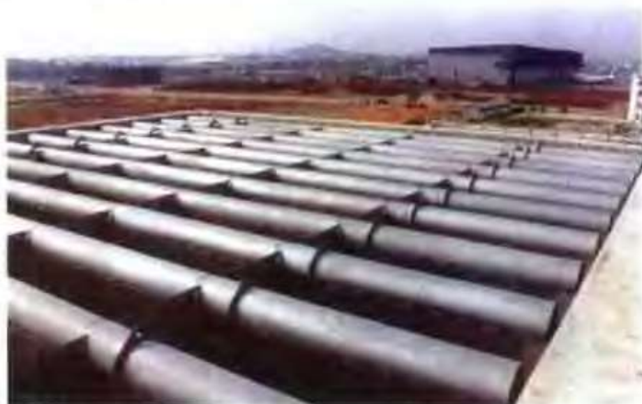
大型航空发动机试车台进气口片式消声器
